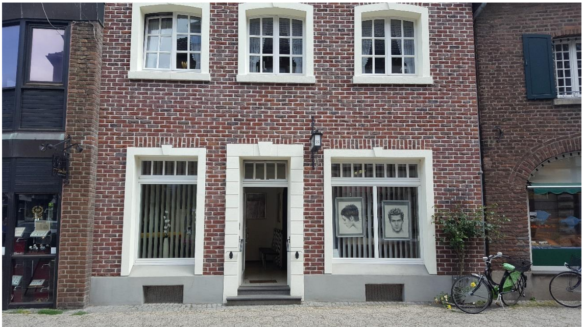
Materialien, die nicht zu dem Gebäudetyp passen (oben Beispiel aus Hüsten) und auf die Bauepoche abgestimmte Farben und Materialien (Beispiel aus Kempen)
