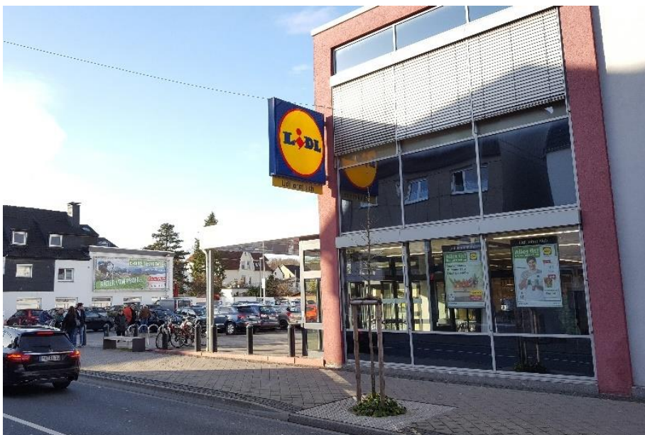
Beispielhafte Bauten ab den 1990er Jahren
