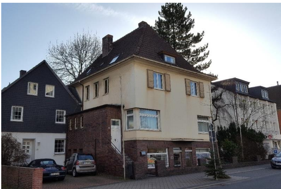
Beispielhafte Bauten aus den 1920er und 1930er Jahren
