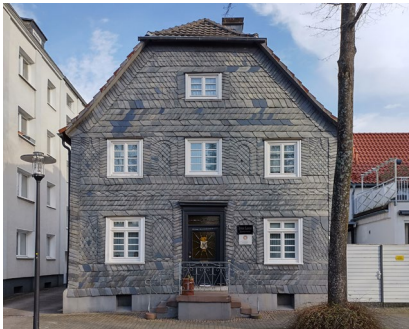
Abbildung 21: Altbaubestand im Strohdorf
