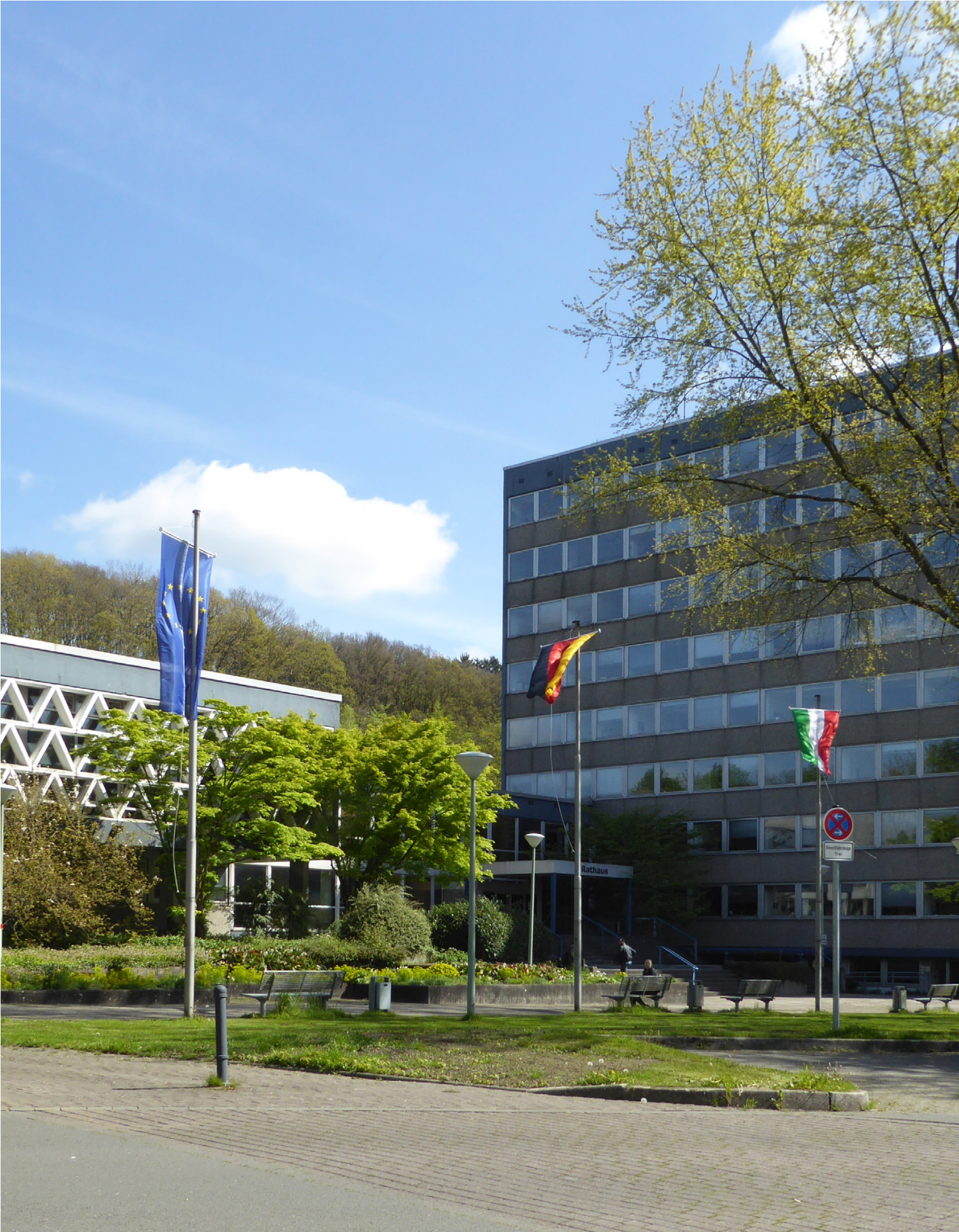
Abbildung 1: Rathaus der Stadt Arnberg, Haupteingang mit Vorzone
