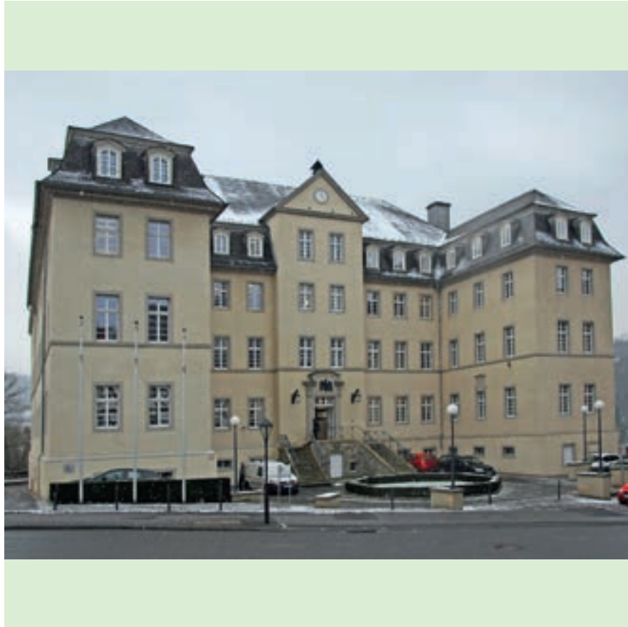
Jägerstraße 1 Alte Regierung, heute Verwaltungsgericht
